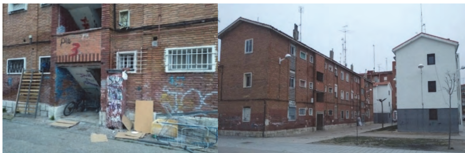
Imágenes 18 y 19: Imagen izquierda, aspecto deteriorado del 29 de Octubre. Fue construido sin cerramiento exterior y sin puerta de entrada. Imagen derecha, comparativa entre la situación original de los edificios y el resultado tras operaciones de rehabilitación que se están llevando a cabo desde 2018 (el autor, 23/01/2020).
