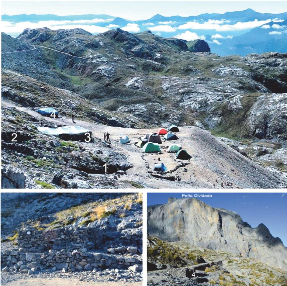
Figura 7.13. Plaza de La Asturiana. Arriba, se aprecia la organización de las labores mineras de exterior en torno a la bocamina, así como el actual campamento espeleológico. 1, bocamina. 2, casetón para la fragua. 3, casetón principal. 4, almacén. 5, distribuidor de vagonetas en la escombrera. Abajo, detalle de las ruinas del casetón principal (izqu.) y el pequeño almacén a la entrada del complejo (dcha.).
