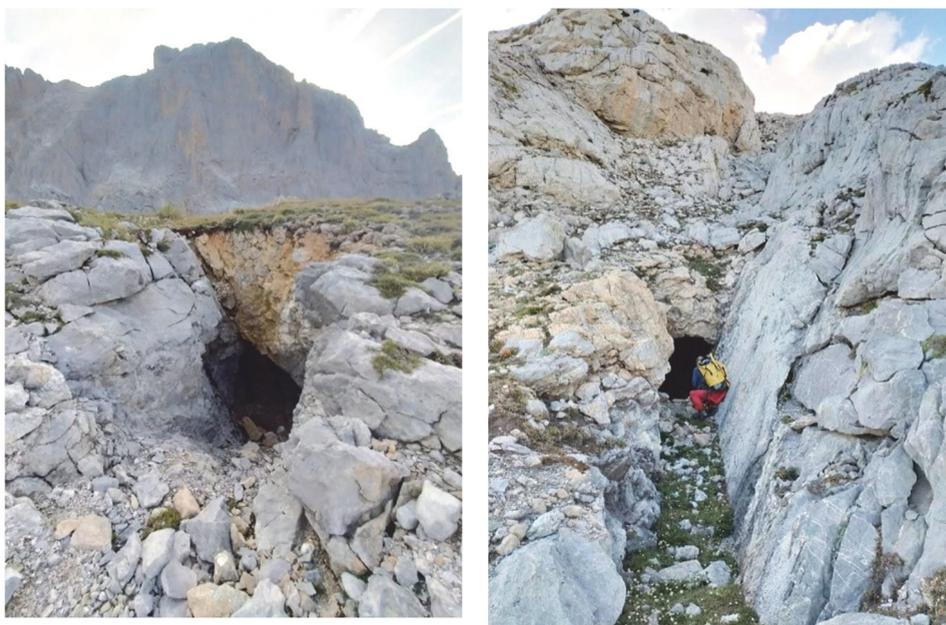
Figura 2.3. Bocaminas y cata minera abiertas en sendas fracturas con dolomitización en el Cueto de Las Gramas.
