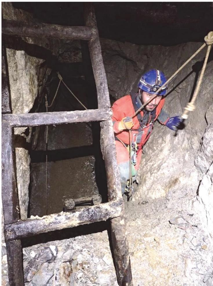
Figura 6.8. Escalas de acceso a testereros en Las Gramas de Arriba (ES7). Se aprecia la instalación de un paso alternativo con anclajes y cuerdas para evitar la utilización de las escalas.
