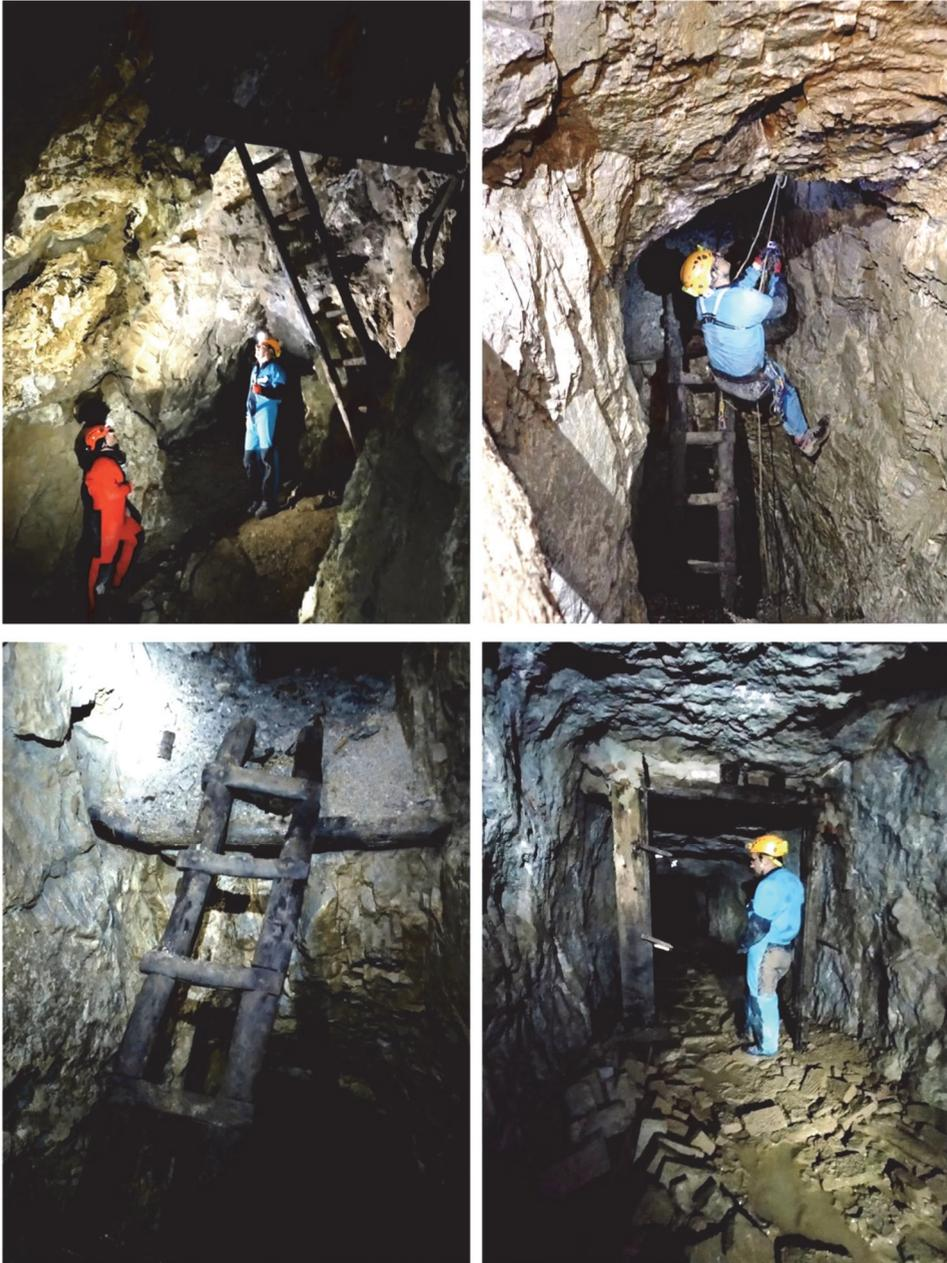
Figura 6.16. Galerías con escalas de acceso a los tajos y galería de transporte con puerta de madera en Las Gramas (ES7).
