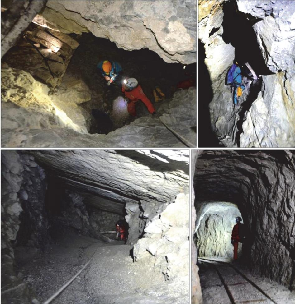
Figura 6.13. Las Gramas Altas. Arriba, pozos de accesos; abajo rampa con el techo siguiendo la estratificación y galería de estéril.
