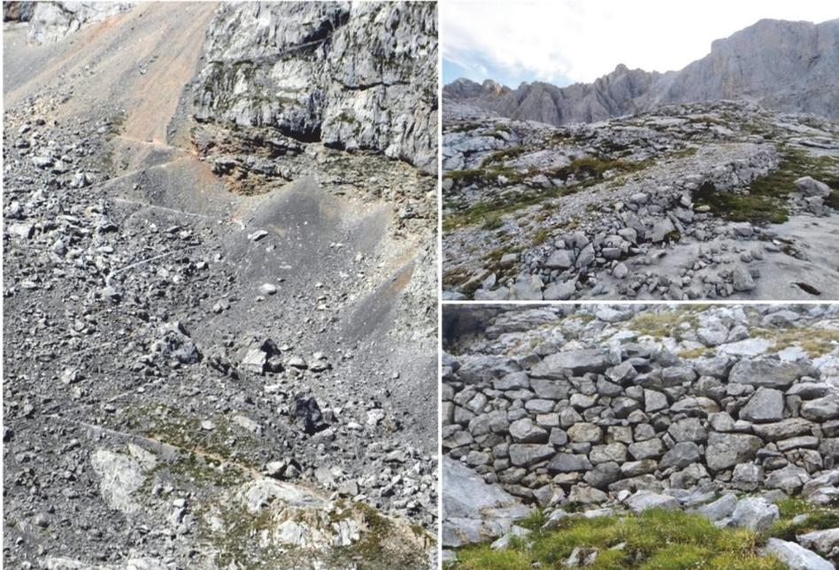
Figura 4.13. Caminos mineros. Izquierda, senda de La Canalona frente al Cueto de Las Gramas. Se aprecian las zetas construidas sobre la pedrera y el camino excavado en la pared. Arriba, a la derecha el camino carretero de Las Gramas de Arriba y abajo detalle constructivo del camino de la Vueltona.
