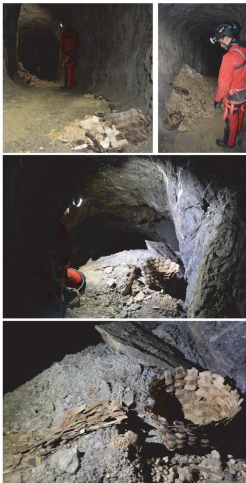
Figura 7.5. Galería en estéril con acumulaciones de mineral y cestos para el transporte calaminas.
