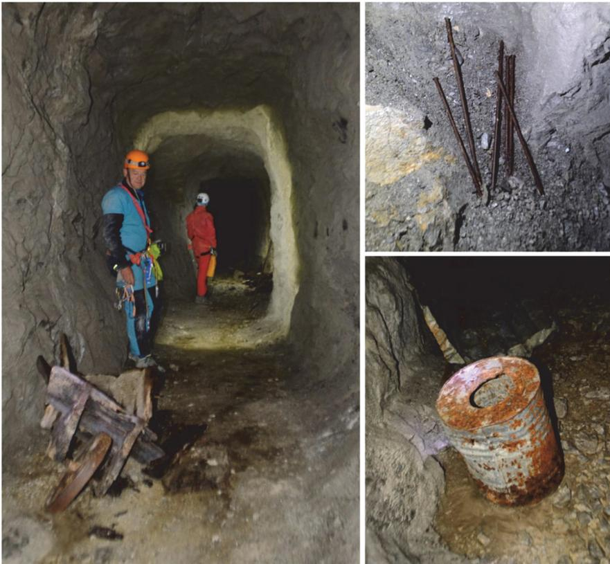
Figura 7.6. Carretilla para transporte, barrenos y botes de carburo en la galería de estéril de acceso a los tajos.
