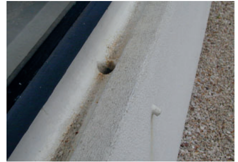
Figura 16. Detalle de la canaleta de recogida de agua bajo la ventana de planta baja en la fachada sureste de la Villa Savoye. Fotografía de Enrique Villar.
