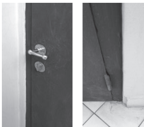
Figura 4. Marco exterior enrasado y picaporte; marco interior y bisagra de las puertas de la Villa Savoye . Fotografías del autor.
