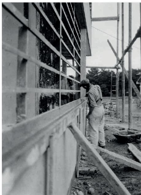
Figura 7. Fotografía del enfoscado del pesebrón del ventanal de la fachada trasera en planta baja de la Villa Savoye , en septiembre de 1929. FLC L2 (17) 198.
