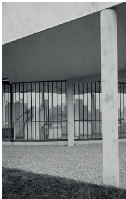
Figura 13. Bajante adosada a la vidriera curva de la planta baja de la Villa Savoye. FLC L2 (17) 022 y FLC, Fondo fotográfico Felix Thyès, 1966, nº 11.
