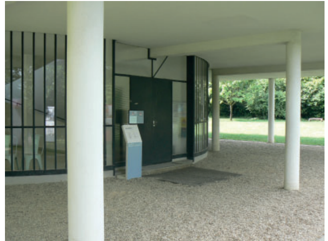
Figura 9. La doble puerta de entrada a la Villa Savoye vista desde el exterior. Fotografía de Jorge Ramos.
