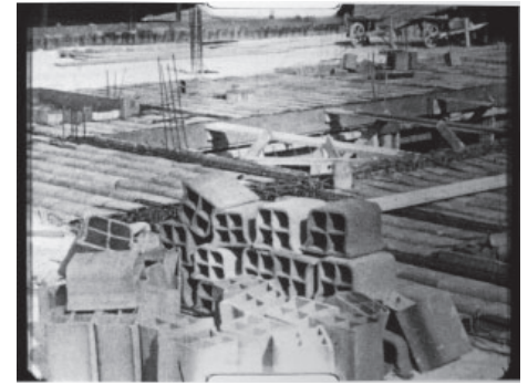
Figura 36. Fotograma donde aparecen las bovedillas de la Villa Savoye en la filmación amateur de Weissmann, 14-5-1929. BOONE, Veronique. Dans l'intimité de l'Atelier du 35, rue de Sèvres. Point de vue d'un amateur, Ernest Weissmann. Bobines inédites /1929-1930 ; Catálogo de la exposición en la FLC, París, 2017.
