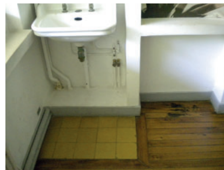
Figura 15. Recuadro de gres bajo los lavabos de planta baja de la Villa Savoye. Fotografía del autor.
