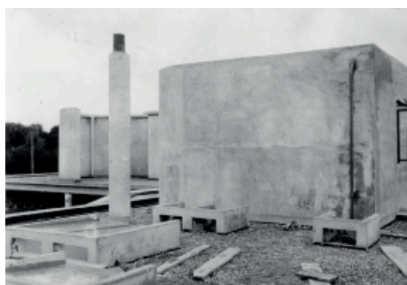
Figura 6. Fotografía del exterior de la rampa recién enfoscada de la Villa Savoye , en septiembre de 1929. FLC L2 (17) 195. Fotografía del cuerpo de la escalera recién enfoscado de la Villa Savoye , en septiembre de 1929. FLC L2 (17) 196.
