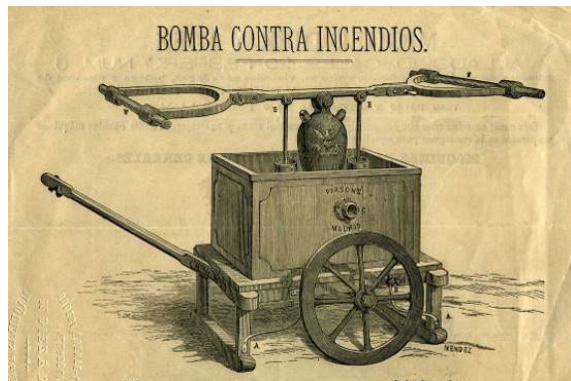
Catálogo de Miguel Diez y Diez , Valladolid, c. 1877, que reproduce una bomba de incendios con un cántaro –ya simbólico– como soporte del eje de la bomba. Col. B.O.
